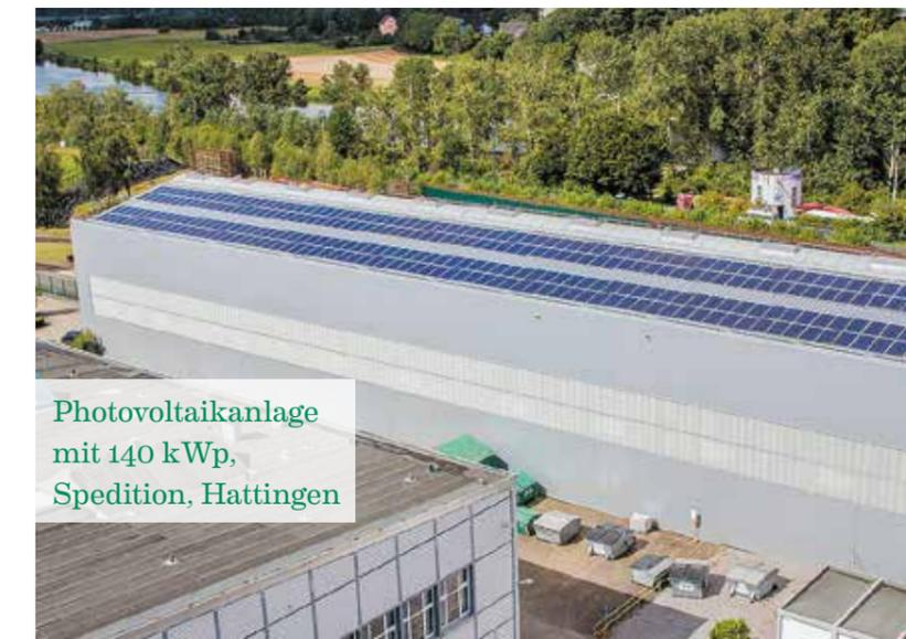
Photovoltaikanlage mit 140 kWp, Spedition, Hattingen
