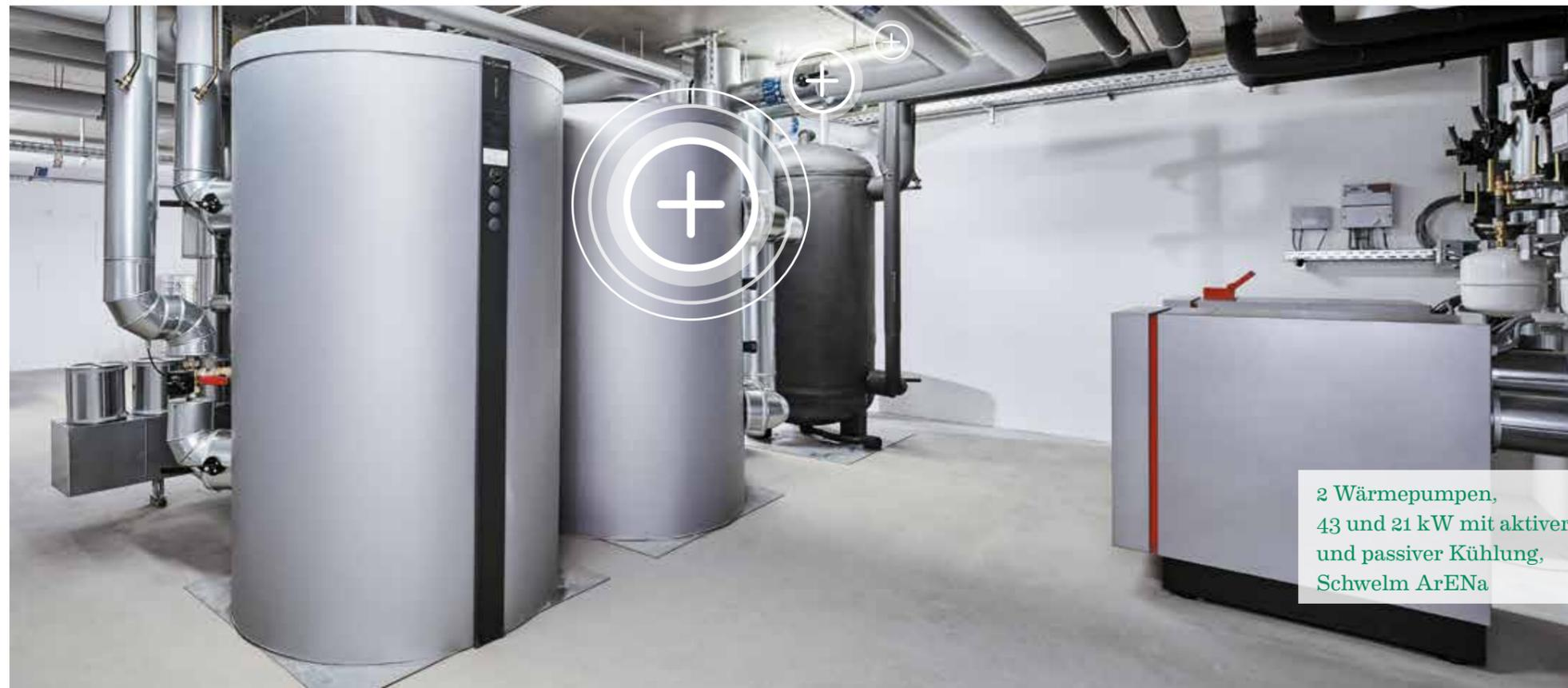
2 Wärmepumpen, 43 und 21 kW mit aktiver und passiver Kühlung, Schwelm ArENa
