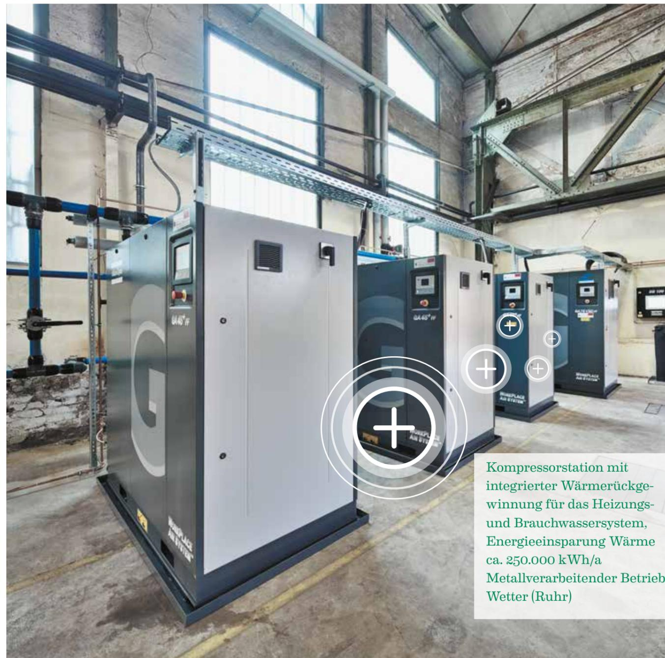
Kompressorstation mit integrierter Wärmerückgewinnung für das Heizungs- und Brauchwassersystem, Energieeinsparung Wärme ca. 250.000 kWh/a
