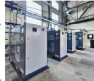
Energieeffizient bei EZM: Die Wärmerückgewinnungskonzept mit einer Gesamtleistung von 200 kW und einer Druckluftherzeugung von circa 40 Kubikmeter pro Minute
